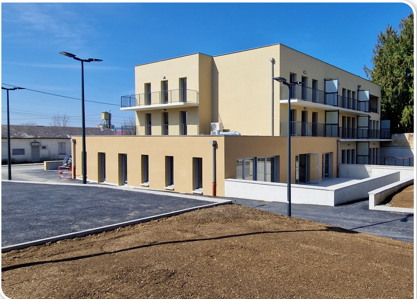
La résidence « Les 3 Arches »
