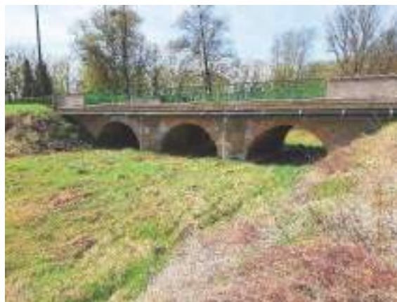
Figure 15 : Vue aval du pont traversant le bras de décharge en rive gauche de la Chiers le plus proche de l'entrée de Douzy (IRH IC, 11/04/2022)
