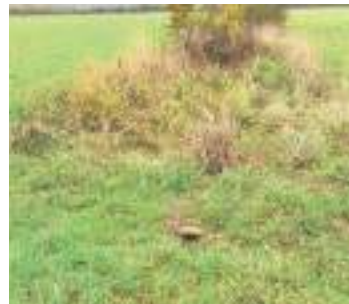
Canalisat  n bouch  e en aval du foss  
