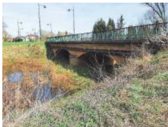
Figure 16 : Vue aval du pont traversant le bras de décharge en rive gauche de la Chiers le plus éloigné de l'entrée de Douzy (IRH IC, 11/04/2022)
