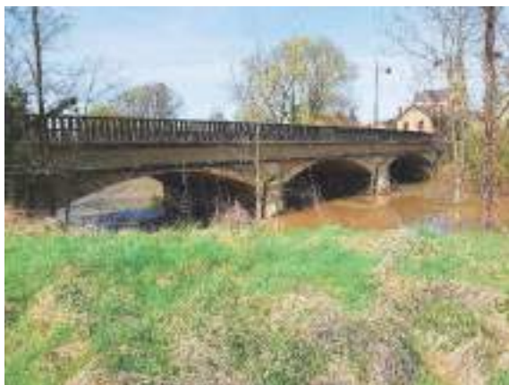
Figure 14 : Vue amont du pont traversant la Chiers à l'entrée de Douzy (IRH IC, 11/04/2022)
